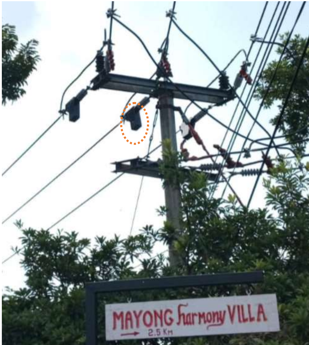
GAMBAR 7. TEKEP ISOLATOR STRAINCLAMP/TEKEP ISOLATOR CONNECTOR CCO DISAIN BARU MENGAMANKAN ISOLATOR TARIK DARI GANGGUAN BINATANG
