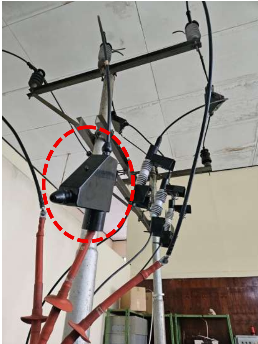
GAMBAR 4. PEMASANGAN TEKEP ISOLATOR STRAINCLAMP UNTUK COVER SAMBUNGAN KABEL MVTIC/XLPE TERHADAP MVTIC/XLPE/A3CS
